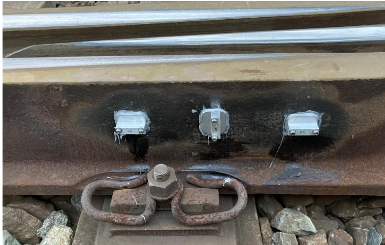
Obrázek 3: Nerezová podložka s krytkou šroubů na stojně
