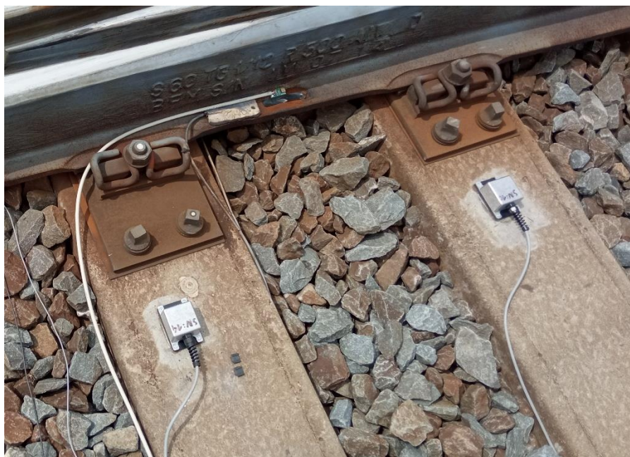
Obrázek 2: Akcelerometry nalepené v trati (2x pražec + kolej)
